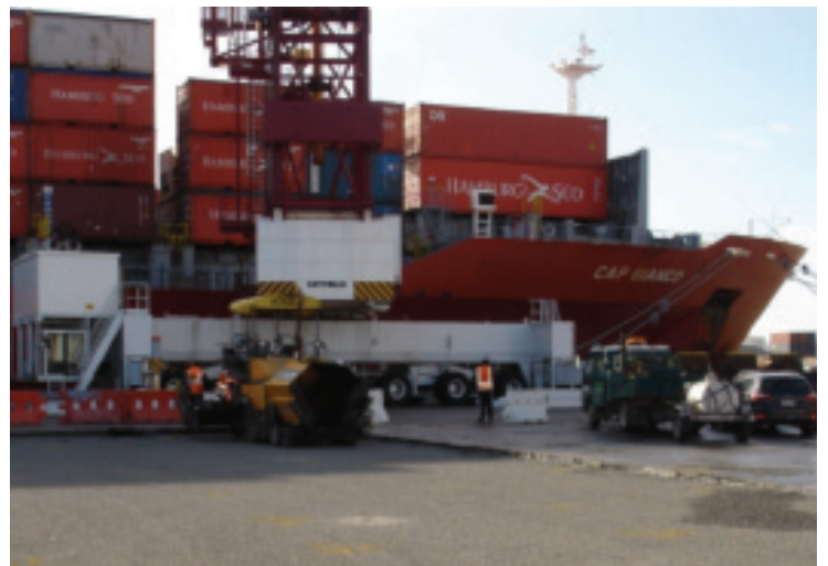
Новый нижний слой из высокомодифицированного асфальта в порту Нейпир, Новая Зеландия.
