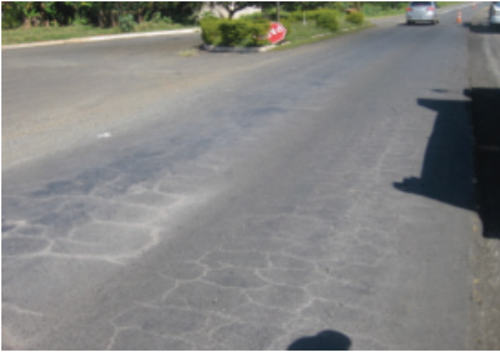
Сильно растрескавшийся участок шоссе PR-092 в штате Парана, Бразилия до реконструкции
