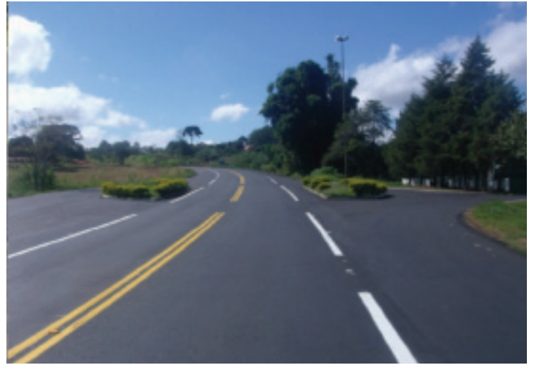
Шоссе PR-092 после замены старого асфальтового покрытия толщиной 30,5 см высокомодифицированным асфальтовым покрытием толщиной 16,5 см; толщина покрытия уменьшена на 45%.
