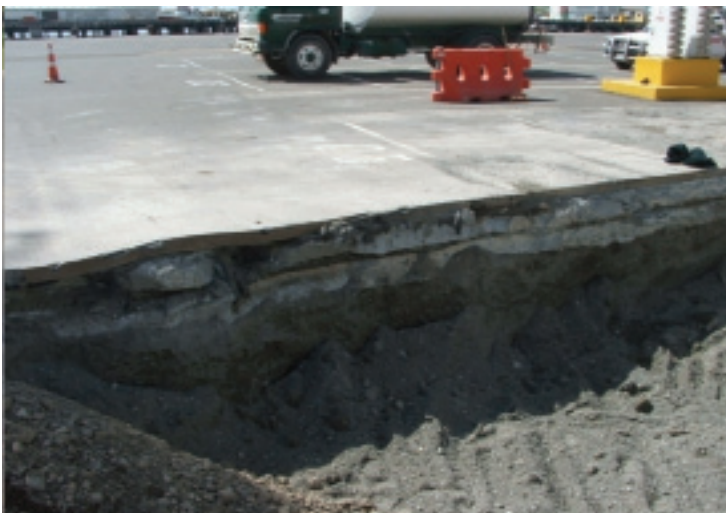
До реконструкции: глубокие колеи в покрытии контейнерной площадки в порту Нейпир, Новая Зеландия.
