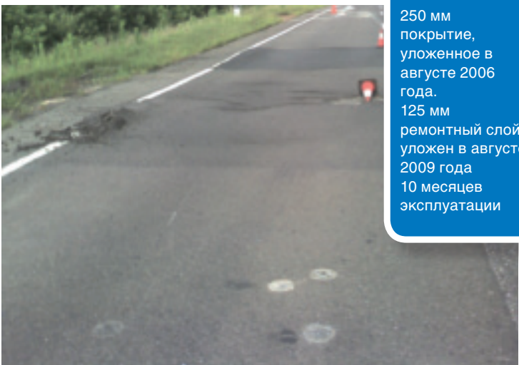
Июнь 2010 г. – участок N8 (NCAT) через 10 месяцев после стандартного ремонта, 4 миллиона ESAL (эквивалент нагрузки от прохода одинарной оси). Первая трещина появилась при 2,7 миллиона ESAL.
